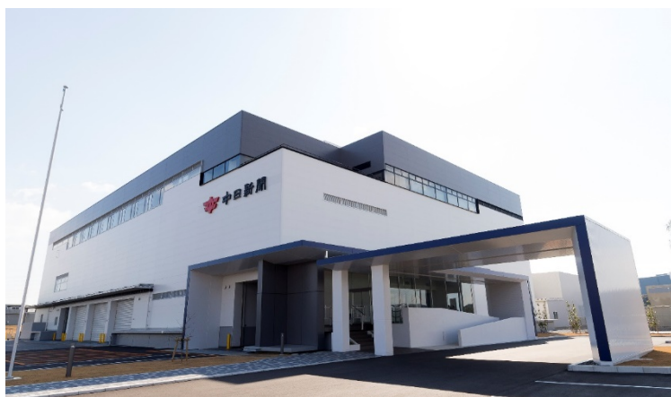
約 2 万 7,000 平方メートルの敷地に建てられた浜松都田工場。
