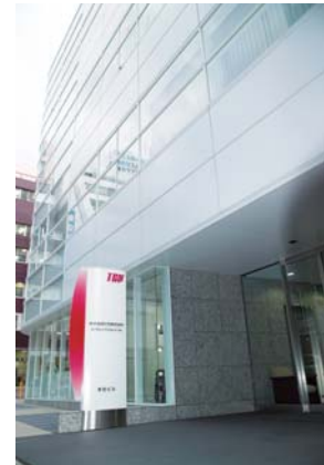
平成19年完成の東洋美術印刷の本社ビルディング。
